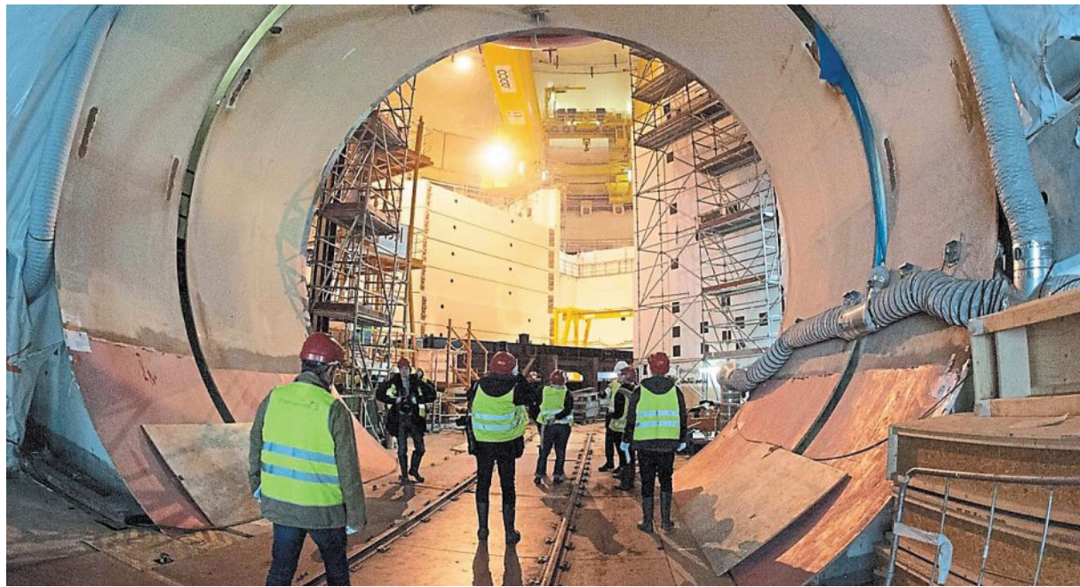
Dans le bâtiment réacteur de l'EPR de Flamanville, qui doit démarrer fin 2018.
